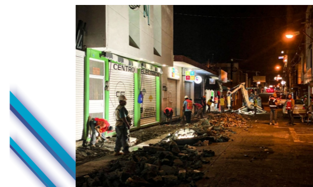
Alumbrado Carretera Los Reyes a La Higuera
