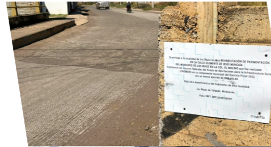
Construcción Pavimentación Calle Clemente de Jesús Munguía Col. El Molino.
