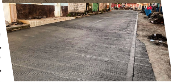
Rehabilitación de Pavimento, Calle Ignacio González, Col. Santa Rosa.
