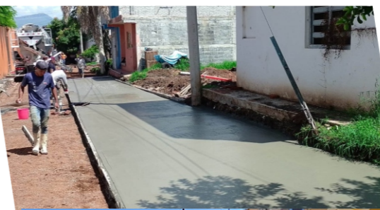
Construcción Pavimento, Calle Privada Juan de la Barrera, Col. "Potreros de Santa Rosa"
