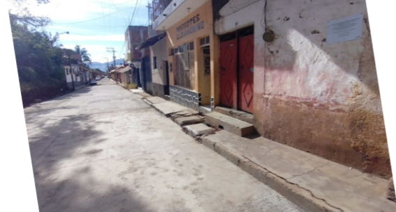
Construcción Pavimento, Calle Morelos Localidad Atapan
