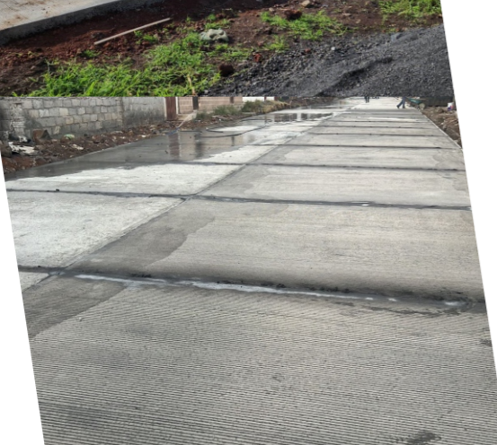
Construcción Pavimentación, Calle José María Martínez, Col. Obrera
