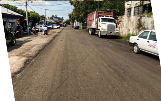
Rehabilitación Pavimento asfáltico, Av. Morelos, Localidad San Sebastián.
