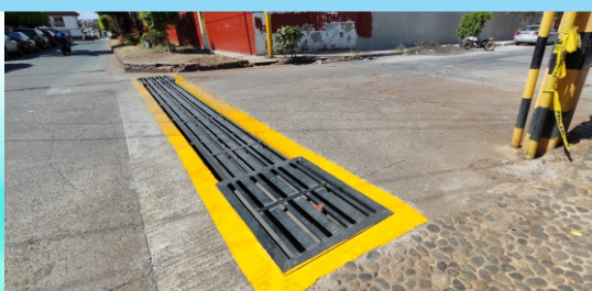
Colectores pluviales
