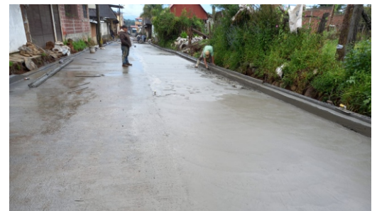
Pavimentación calle Francisco Villa, Sicuicho
