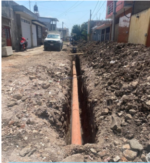
Construcción de red de drenaje, calle Marte, col. Lomas 2
