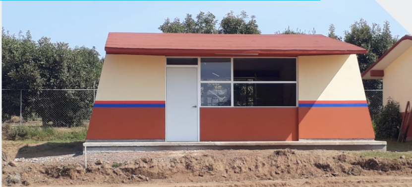
Construcción de aula, Telesecundaria Capitán Roberto Cerano Cervantes, Cherato
