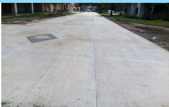
Pavimentación, calle Hidalgo, San Isidro
