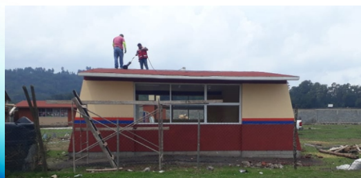
Construcción de aula en el Preescolar Erandimani, Santa Rosa
